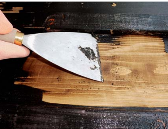
Einsatz eines lösemittel- haltigen Abbeizers.
