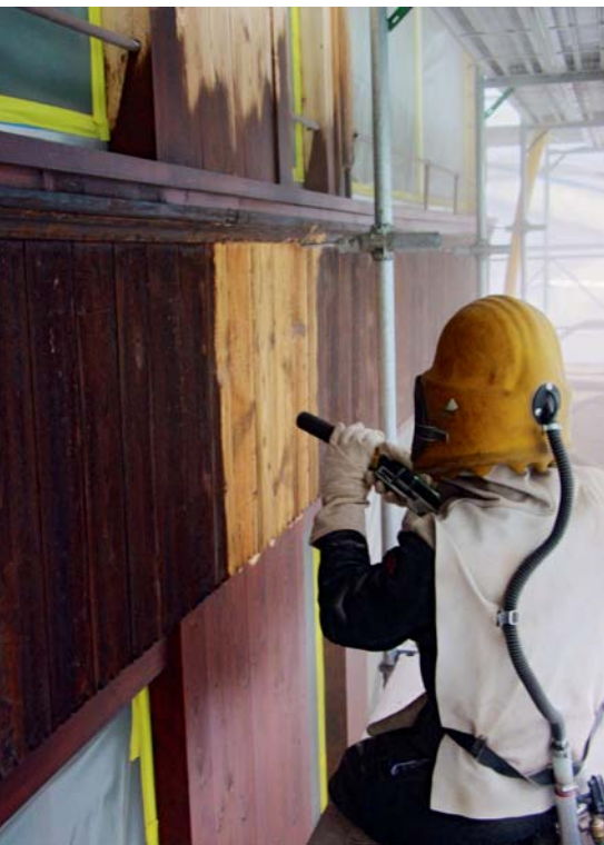
Abstrahlen einer thermoplastischen Altbeschichtung.
